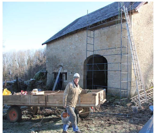
Travaux de sécurisation et de consolidation
